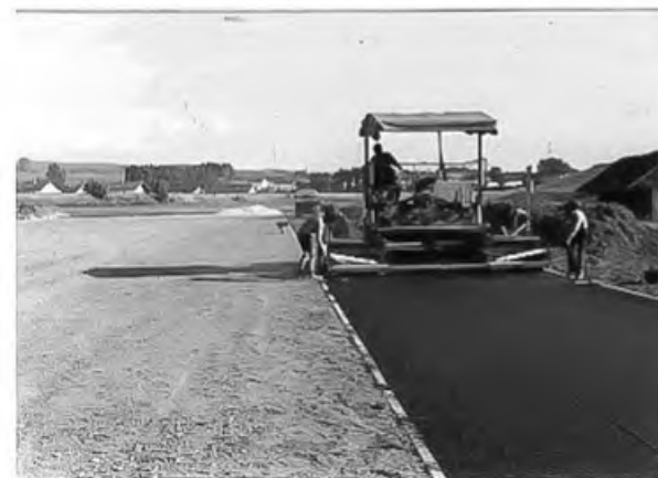
mit dem Fortiger wird die Laufbahn einge- baut,
