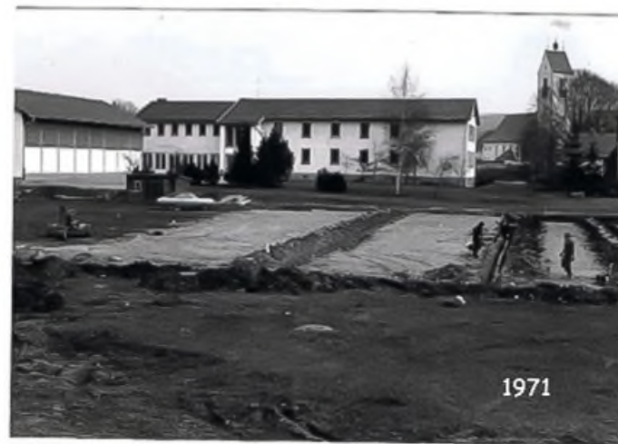
Die Untergrundplanie ist fertig. Die Entwässerungsleitungen werden verlegt.
