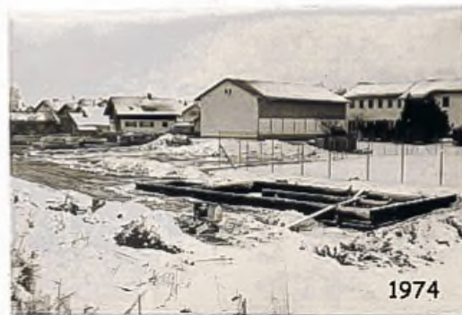
Der Saal für den dritten Platz ist abgebrochen. Die Fundamente des Tennisheimes stehen.
