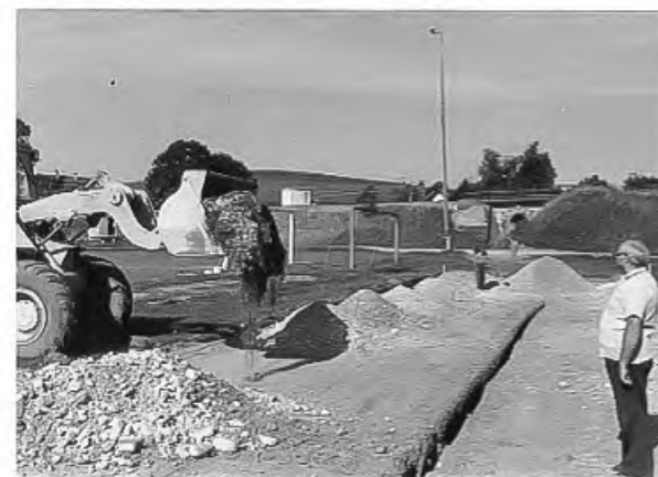
die Einstockbahn wird aufgeküst, in der Mitte die Ent- wässerungsleitung.
