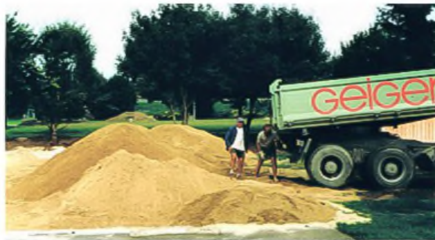
der spezielle Sand wird angeliefert
