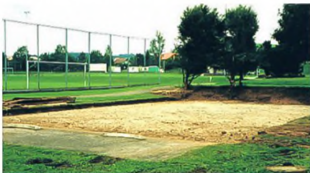
der Unterbau für den Beach-Volleyballplatz ist fertiggestellt
