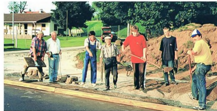
die Verlegung der Holzeinfassung und der Randplatten übernahmen die Stocksützen
