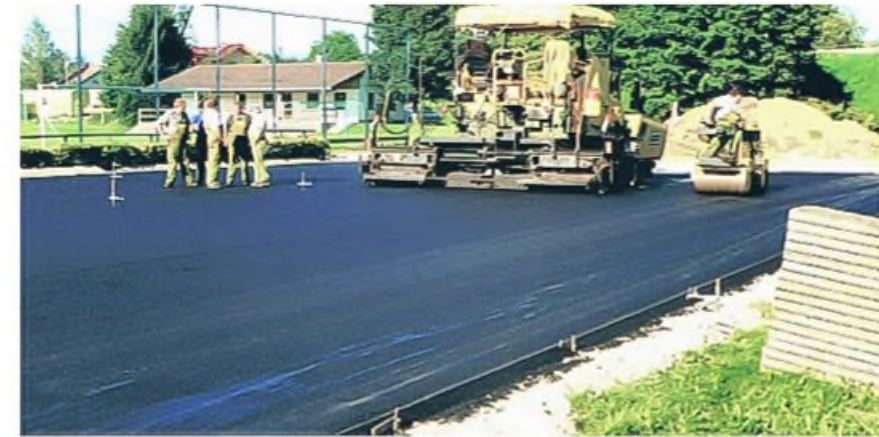
der Belag wird durch einen Fertiger aufgebracht
