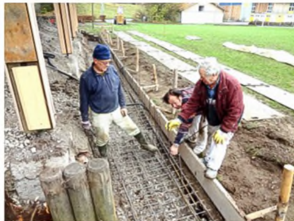
Das Fundament wird hergestellt v.li.: Xaver Wankerl, Ossi Diepold, (Mitarbeiter Baugeschäft Höbel), Josef Höbel (Baugeschäft)
