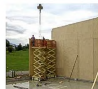
Aufstellen Trenn- und Außenwände
