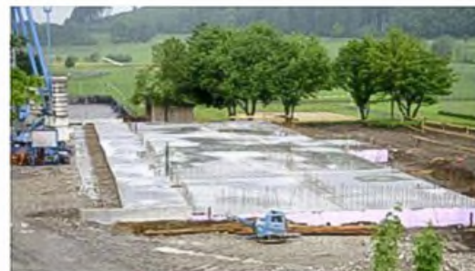
Betonplatte Umkleideräume Geräteraum <<<<<
