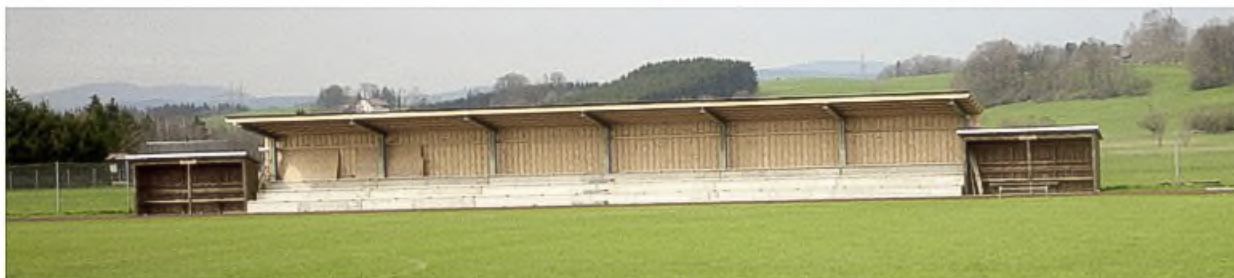
Die fertige Zuschauertribüne mit der eingesetzten Rückwand und den Ersatzspieler-Häuschen links und rechts
