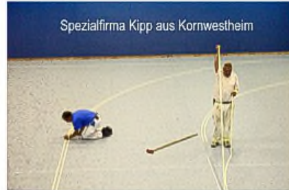
Auf dieser Unterkonstruktion werden die Holzelemente für den Schwingboden befestigt
