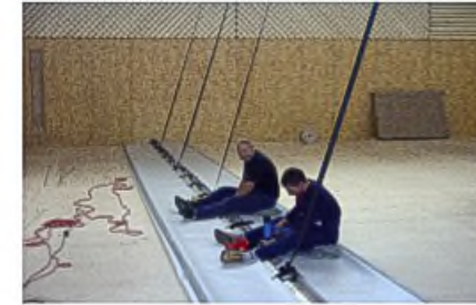
Die Halle kann mit 2/3 zu 1/3 getrennt werden. Die Bahnen aus PVC werden am Boden ausgelegt, zusammengesetzt und anschließend hochgezogen
