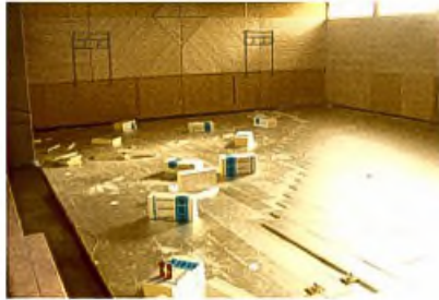
Es folgt die Verlegung der Isolierplatten
