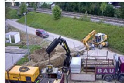
Inzwischen wurde die Fernheizung verlegt. Die neue Sporthalle wird an die Heizung der Schule angeschlossen. Es musste der Bahndamm durchpresst werden.
