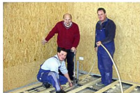
Bei der Fußbodenheizung in der Sporthalle müssen ca. 2000 m Heizungs-schläuche verlegt werden.
