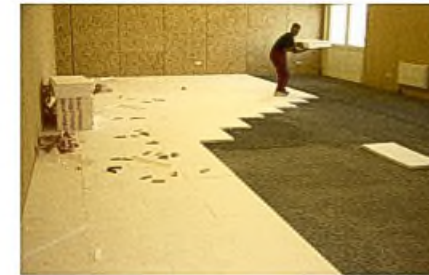
Nach einer Ausgleichsschüttung in Kraft- und Gymnastikraum werden darüber Dämmplatten verlegt
