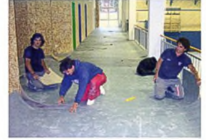
In allen Räumen und der Tribüne wird abschließend der LINO-Boden verlegt
