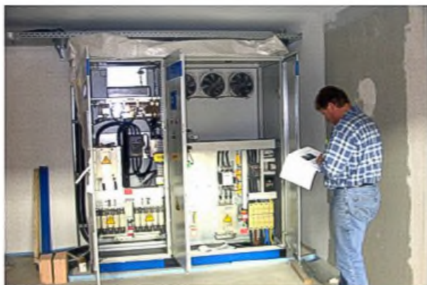
Der Wechselrichter mit Innenleben
