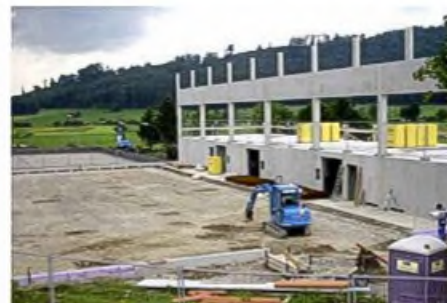
Planie für Hallenboden, Setzen der Gerätehülsen
