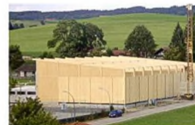
Versetzen der Holz-Wandteile
