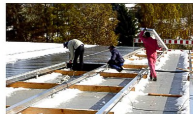
Auf dem Dach werden die Module miteinander verkabelt und auf die Befestigungselemente geschraubt (die Gesamtfläche beträgt 144 KW) linkes Bild: Xaver Wankler, rechtes Bild: Arbeiter der ausführenden Firma (man sieht, der erste Schnee ist schon gefallen (09.11.2004)
