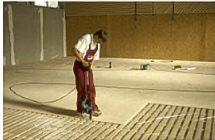
Nach Verlegung einer Klarsichtfolie auf diese Längsbretter werden Mehrschicht-Spanplatten getackert
