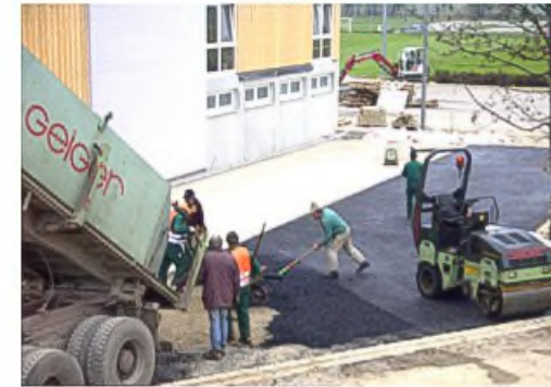
Jetzt kann die Teerkolonie anrücken. Gesteert wird die Zufahrt zu den Parkplätzen und die Verbreiterung der Straße zum Wertstoffhof
