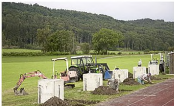
Die Betonfundamente werden gesetzt
