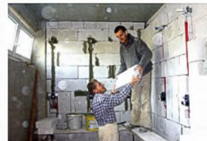
an den sanitären Installationen wird vorgemauert.
