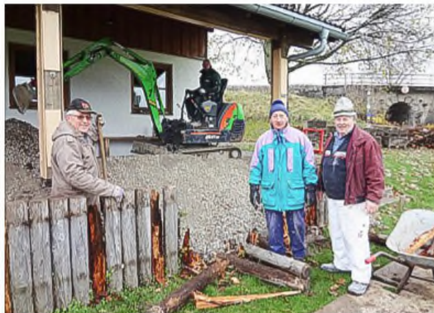
Die alten morschen Palisaden werden abgebaut v.li.: Xaver Wankerl, Randolph Krause (Bagger), Gundolf Weiß, Josef Höbel (Baugeschäft)
