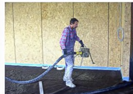
Estricheinbau in der Cafeteria
