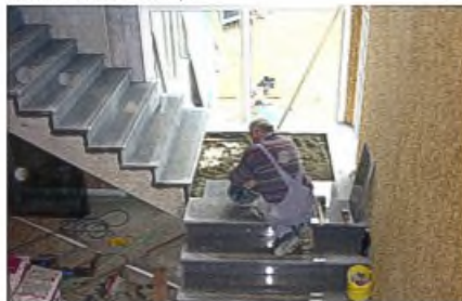
In der Eingangshalle wird die Fertigkeittreppe in das Obergeschoß mit Naturstein belegt
