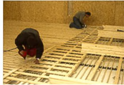
Auf dieser Unterkonstruktion werden die Holzelemente für den Schwingboden befestigt
