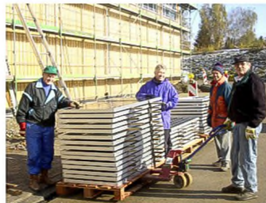
Vorbereitung der Module und Beförderung aufs Dach v.li.: Heribert Rauch, Adolf Bessener, Anton Pfefferle, Eugen Klier
