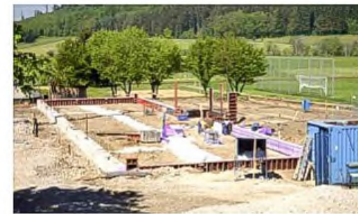
Betonfundament Umkleideräume Nassräume Geräteraum >>>>>
