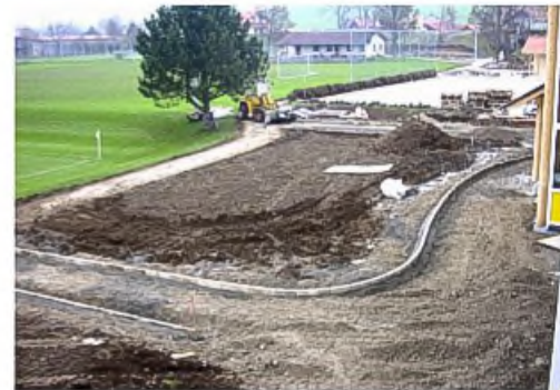
Die Gehwege im Norden. Im Hintergrund das SSV-Sporthaus
