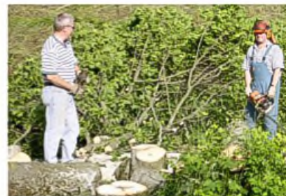
Vor Verlegung von Abwasser- und Wasserleitungen muß noch ein Baum gefällt werden.
