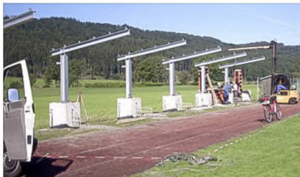
Die Eisenträger werden eingebaut
