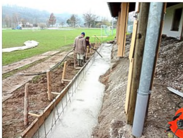
Das Fundament wird betoniert v.li.: Xaver Wankerl, dahinter Ossi Diepold (Mitarbeiter Baugeschäft Höbel)
