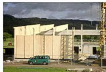
Einsetzen der riesigen Fischbauchträger
