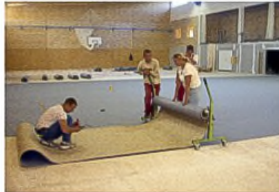
Nachdem die Mehrschichtplatten gespachtelt und geschliffen sind wird der LINO-Hallenboden angeliefert und verlegt
