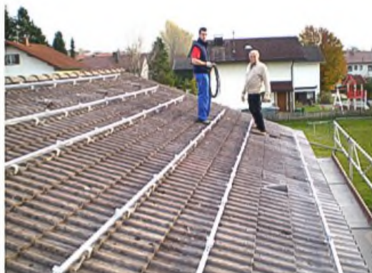
Der Unterbau (tragende Schienen) ist fertig. v.li.: Dominik Wankerl und Xaver Wankerl
