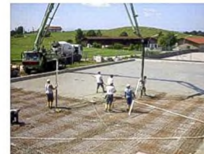
Betonplatte als Unterbau für Hallenboden
