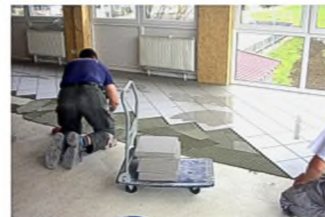
Verlegung der Fliesen in der Cafeteria
