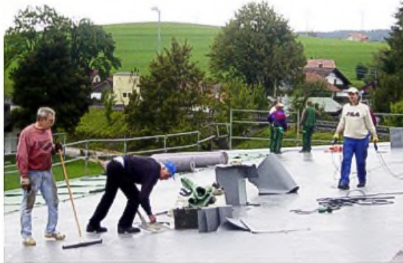
Folienverlegung und Verschweißung v.li.: Xaver Wankel und Arbeit der Fa. Wülfrath
