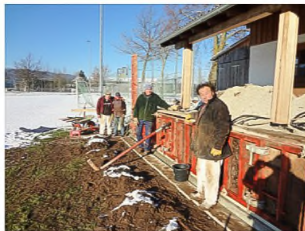
Die Betonwand ist geschalt und betoniert v.li.: Josef Höbel (Baugeschäft), Paul Getta, Bernhard Vagg, Ossi Diepold (Mitarbeiter Baugeschäft Höbel)
