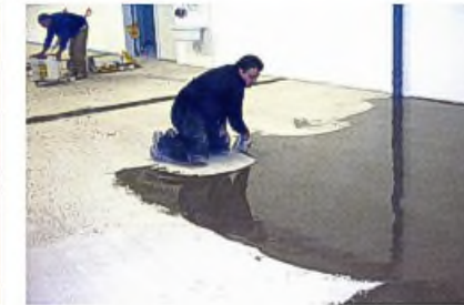
Der Boden im Geräteraum wird versiegelt
