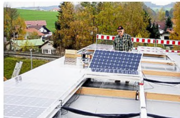
Auf dem Dach werden die Module miteinander verkabelt und auf die Befestigungselemente geschraubt (die Gesamtfläche beträgt 144 KW) linkes Bild: Xaver Wankler, rechtes Bild: Arbeiter der ausführenden Firma (man sieht, der erste Schnee ist schon gefallen (09.11.2004)
