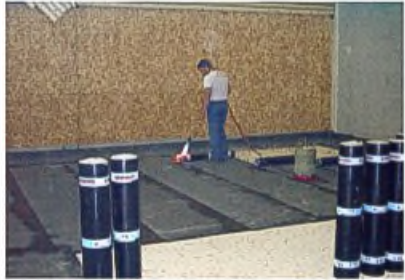
Zuerst werden auf dem Betonboden die Schweißbahnen verlegt und miteinander verschweißt
