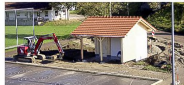
Der Unterstand mit Satteldach und Geräteraum ist fertig
