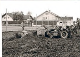
Rudolf Frey weist dem Baggerführer den richtigen Weg
