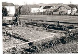
... eine Baustelle mit Pfiff!
