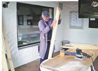
Sigge Arnold musste die Holz-Sitzbänke von den Umkleidekabinen abschleifen
