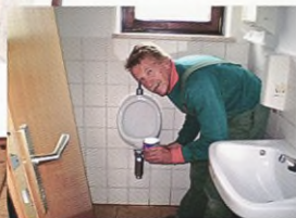
Adolf Grillinger war für die Arbeiten im WC zuständig
