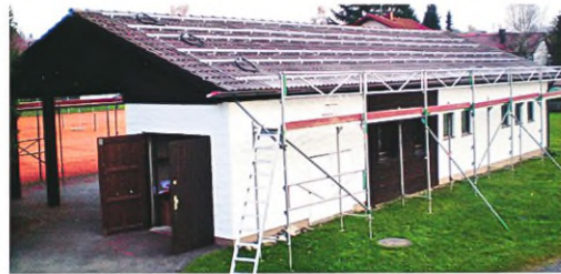
Unterkonstruktion Tennisheim Westseite
