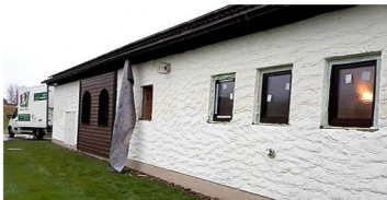
Fenstereinbau auf der Westseite
