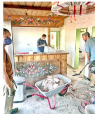
Peter Seitz (li), Manne Schweighart (mitte) und Rosch Quadflieg räumen den Bauschutt weg
