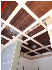
Die Unterkonstruktion ist fertig.
