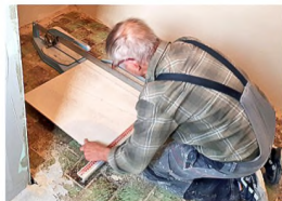
zuschneiden der Fliesen
