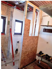
Die OSB-Platten werden montiert . . .
