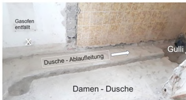
Entwässerung in den beiden Duschen
