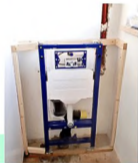
nach der Montage
