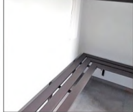
Fertigstellung der beiden Umkleiden
