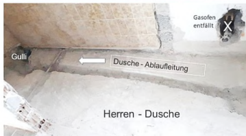
Entwässerung in den beiden Duschen
