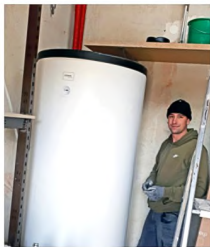
Kilian Hübner bei der Montage und Isolierung
