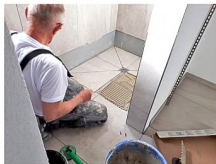
"Momo's" Fliesenarbeiten bis auf das Ausflügen nahezu fertig
