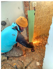
Rosch Quadflieg flext die Türzargen ab
