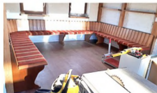
Eckbank wieder fertig eingebaut
