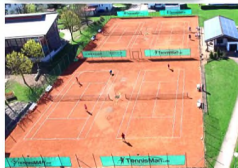
Tennisplätze 2020 - vor der Sanierung
