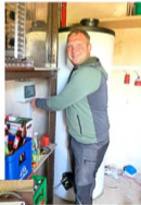
Nico Dorn schließt den Boiler mit Steuergerät im Geäteraum an.
