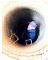
Zuerst wurde von Dietmar Kretschmer das Wasser im Schacht vor dem Heim abgestellt
