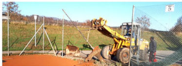
Ein Pfosten des Maschendrahtzaunes muss abgebaut werden damit die Baufahrzeuge in den Platz fahren können
